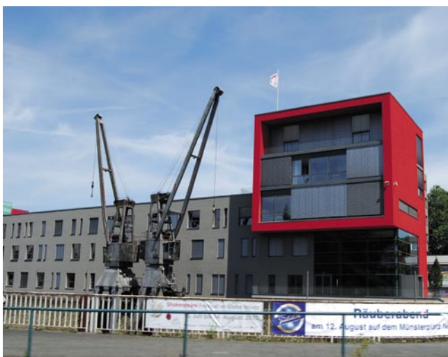
Haus am Pegel an der Neusser Hafenmole 1
