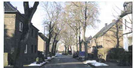
Derikum Aggerstr. | Am Goldberg | Mittelstraße
